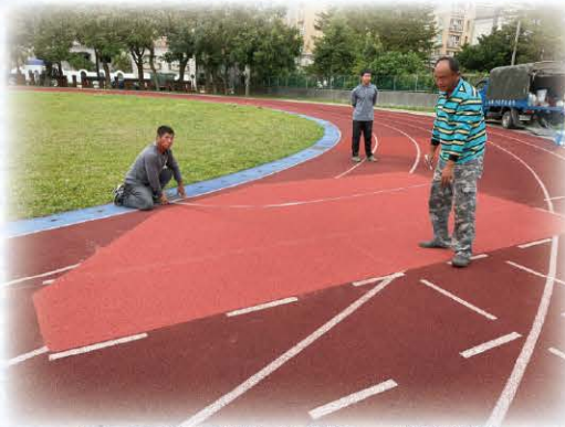
校園修繕改善計畫-操場PU跑道補強
