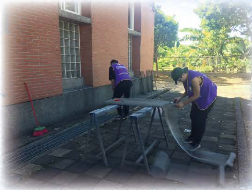
校園修繕改善計畫-環校排水溝加裝不鏽鋼細網預防病媒蚊
