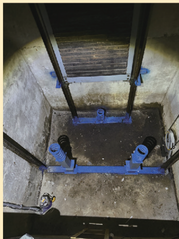
電梯機坑防水檢查
