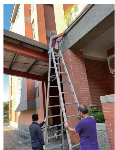
電線脫落處理
