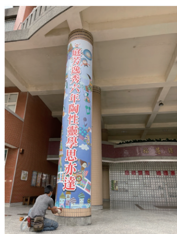
水晶牆梁柱布條損毀更換
