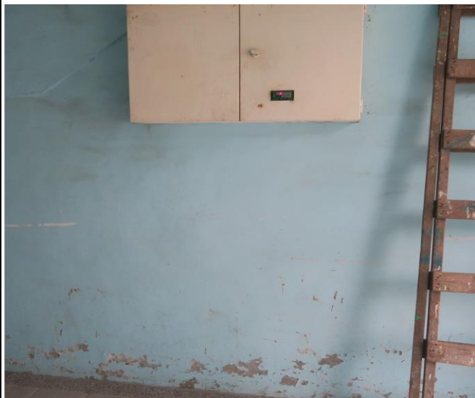
彩繪牆施工前原貌
