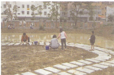
大家分工合作，讓生態池的晶化達到自然防水的目的
