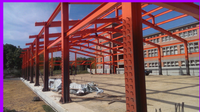
風雨球場鋼骨工程接合
