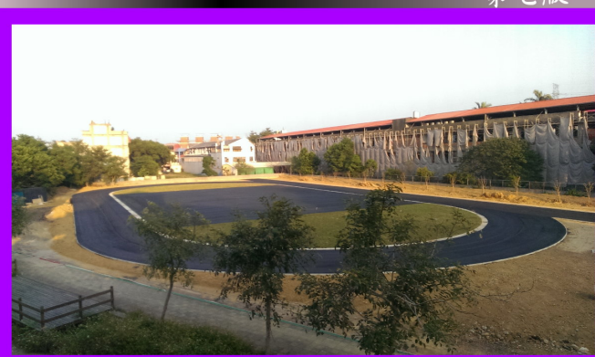
跑道鋪設瀝青混凝土
