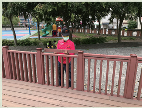
操場旁塑木平台修繕
