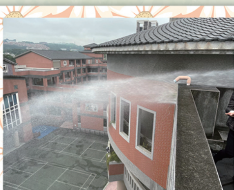
全校消防設備更新驗收完成
