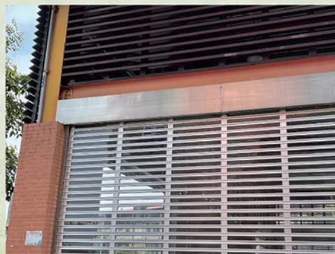
龍騰館鐵捲門遙控修繕完成
