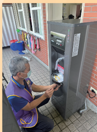
飲水機定期保養及汰換
