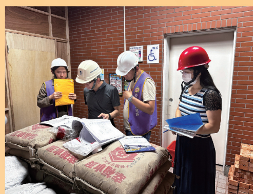
福慧樓廁所整修工程定期督工
