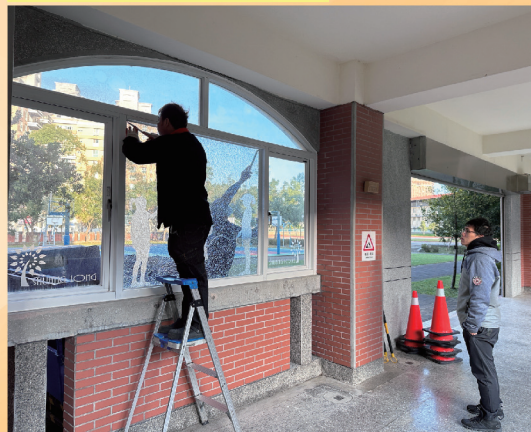
校內設備修繕工程
