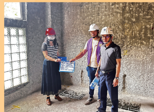
福慧樓廁所整修工程之工程查驗
