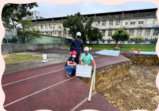
改善校園跑道積水工程施工查驗
