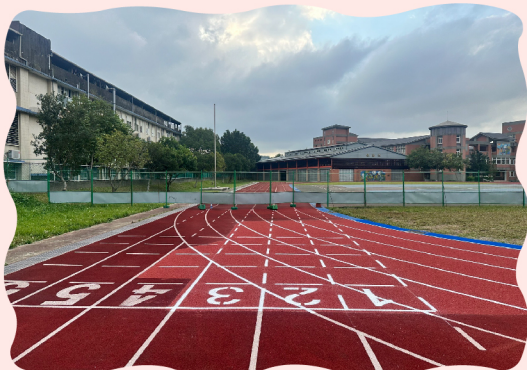
改善校園跑道積水工程完工照片
