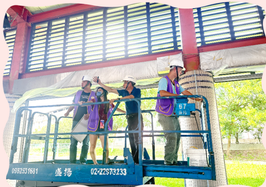
龍騰館除鏽工程施工查驗
