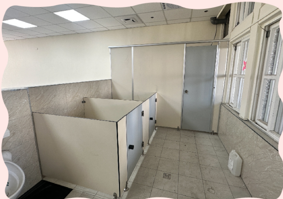
幼兒園兩歲專班工程施工照
