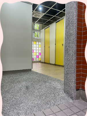
福慧樓廁所完工照
