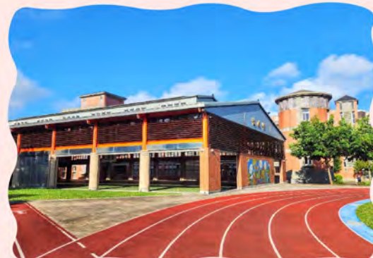
完成除鏽上漆的龍騰館外觀
