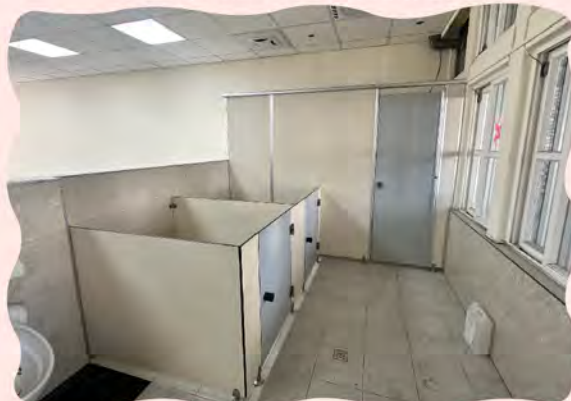
幼兒園兩歲專班工程施工照
