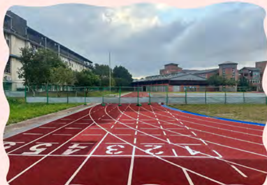
改善校園跑道積水工程完工照片
