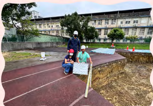
改善校園跑道積水工程施工查驗
