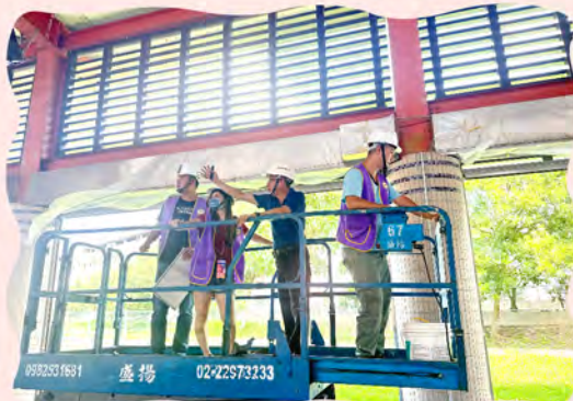
龍騰館除鏽工程施工查驗
