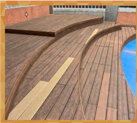
中庭廣場塑木平臺修繕
