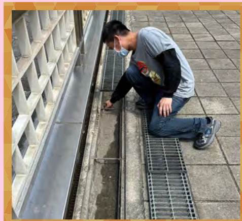
檢視與清除排水溝的淤泥
