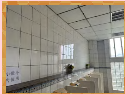
廁所磁磚修繕後
