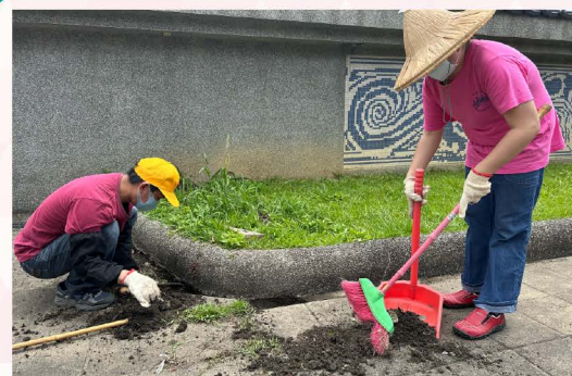
校園排水溝-清除淤泥
