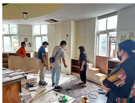
第三期圖書館整修工程
