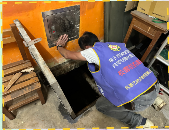
筏基定期檢查排水功能
