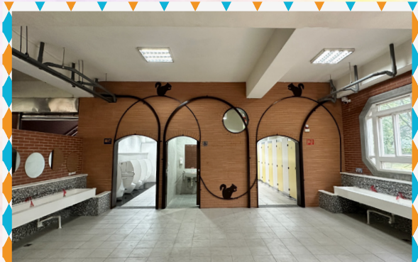
感恩樓廁所整修工程-完工照
