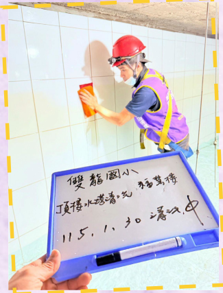
定期進行水塔清洗
