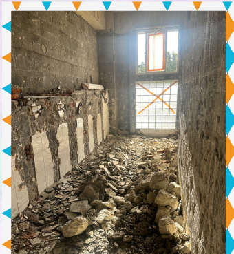
感恩樓廁所整修工程-拆除作業
