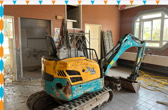
感恩樓廁所整修工程-拆除作業
