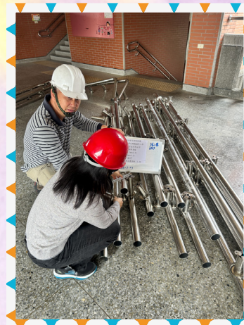
校舍女兒牆工程材料查驗
