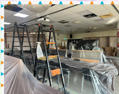
校史室整修工程
