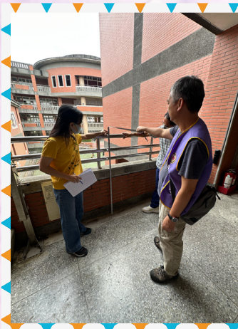
校舍女兒牆欄杆增高為130公分
