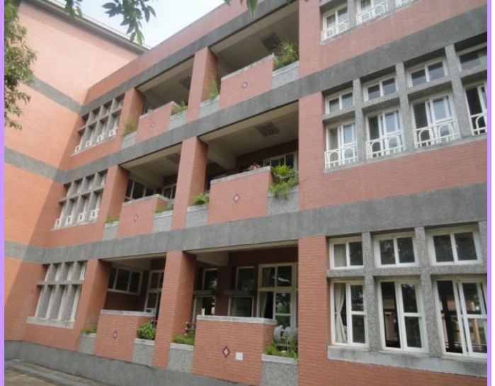
每班均有植栽的陽台
