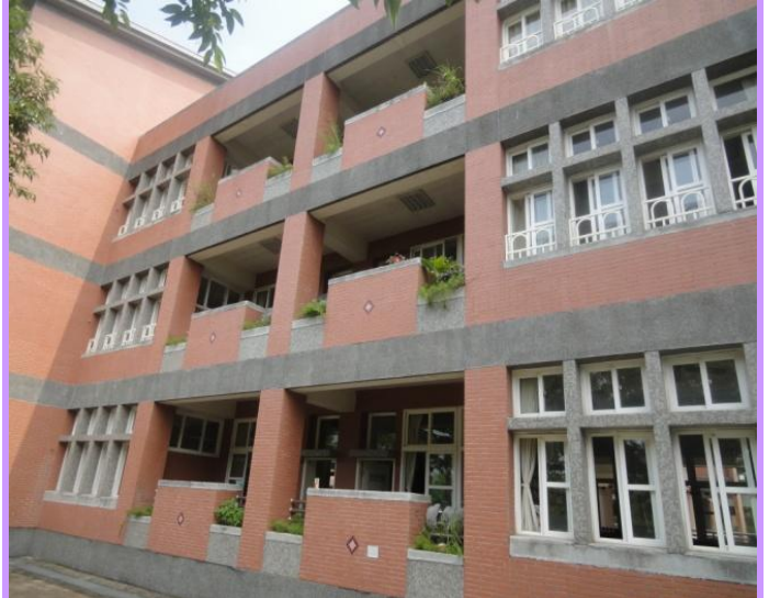
每班均有植栽的陽台
