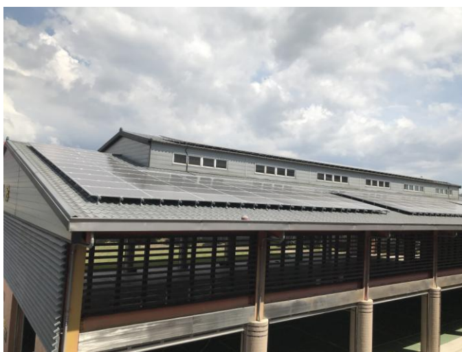
屋頂上裝設太陽能板
