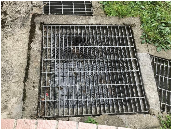
排水溝蓋下方均鋪設紗網防蚊
