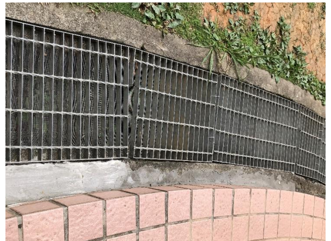
排水溝蓋下方均鋪設紗網防蚊
