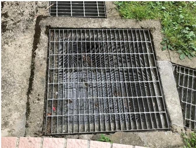
排水溝蓋下方均鋪設紗網防蚊
