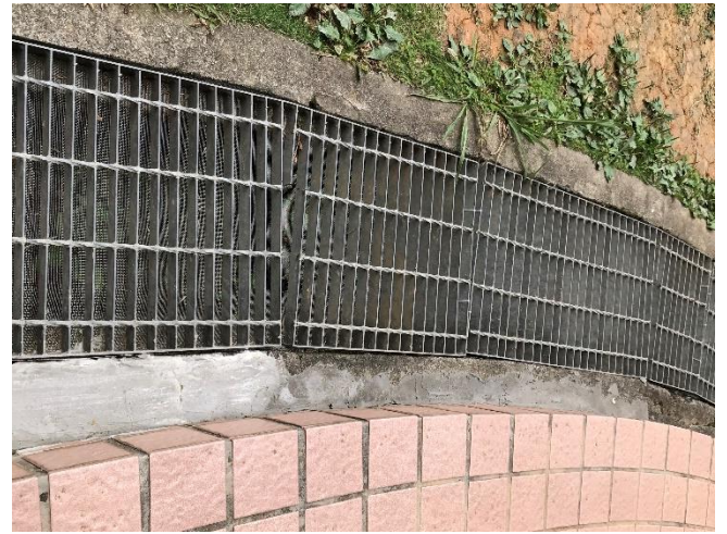
排水溝蓋下方均鋪設紗網防蚊
