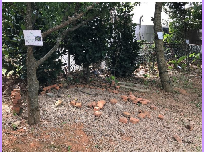
鋪設小碎石防積水
