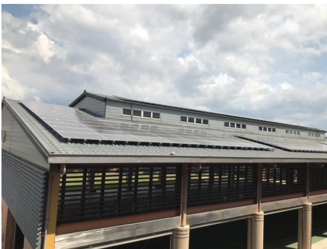
屋頂上裝設太陽能板
