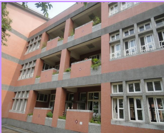
每班均有植栽的陽台
